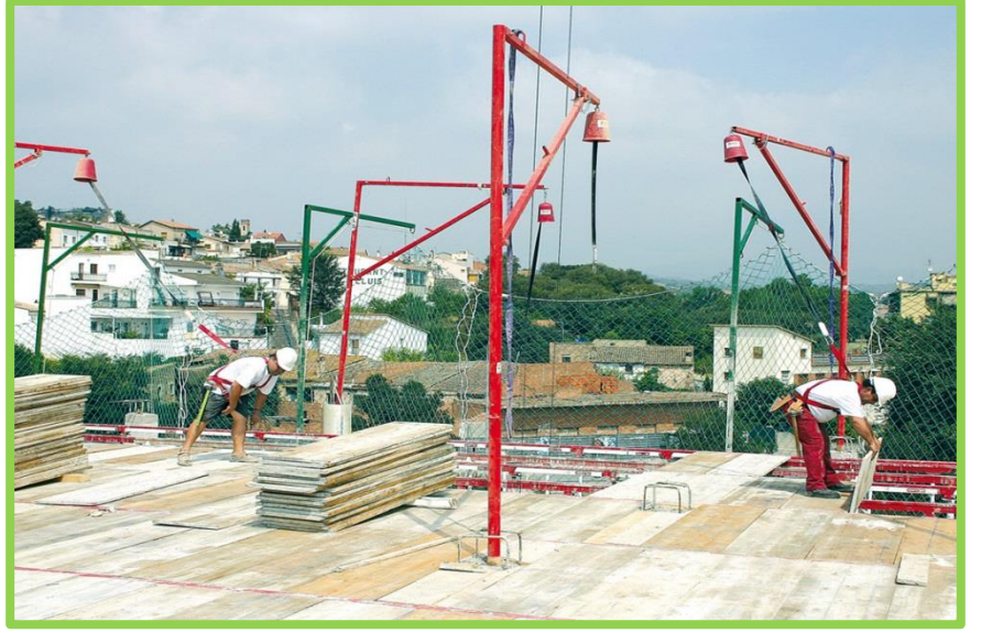
Şekil 5.4. İnşaat kalıp çalışmasında düşmeye karşı koruma [31]
