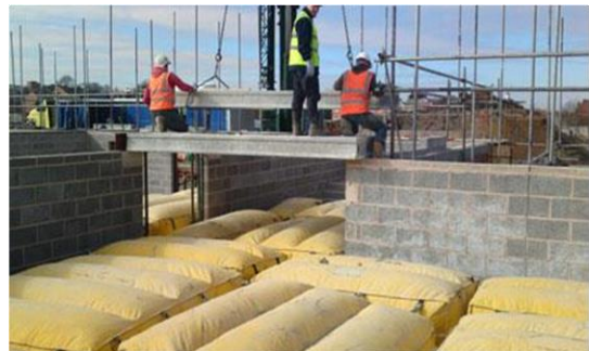
řekil 3.14. Hava yastıęı sisteminin bir inřaatta kullanımı [19]
