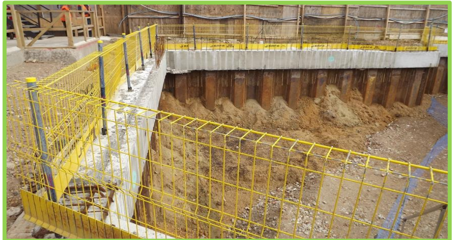
Şekil 5.6. Kazı kenarında düşmeye karşı koruma [33]
