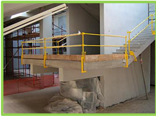
Şekil 5.11. Kat merdivenlerinde düşmeye karşı koruma [37]
